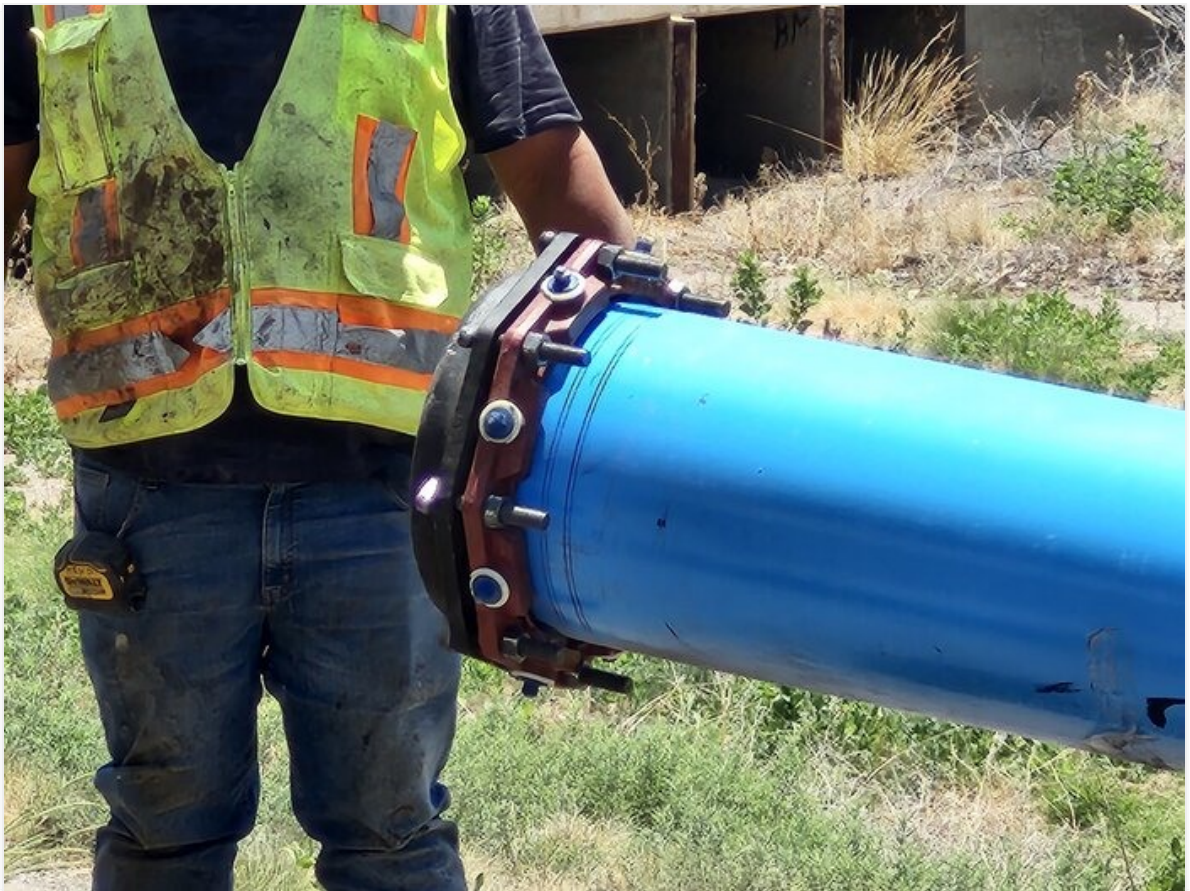
DI cap at sta 62+14 Copper Dr.
