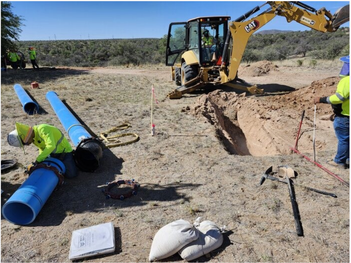
Assembling DI 45 bend at sta 10+34
